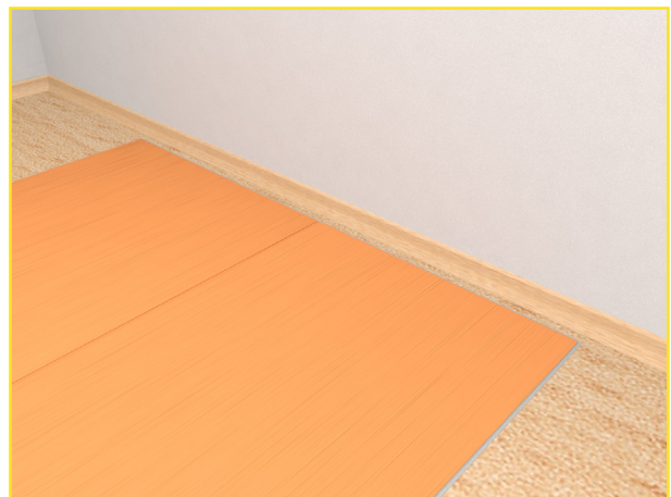
Abb. 22: Schirmmaterial auslegen
