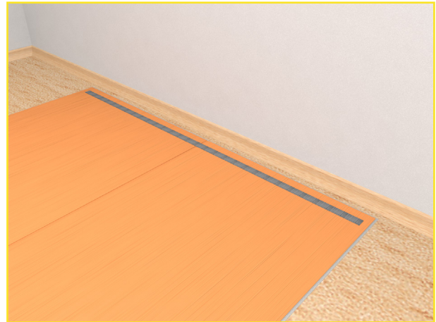
Abb. 23: Erdungsband verkleben (nur bei 2 oder mehr Bahnen)
